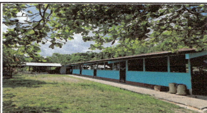
Foto 4: REPARACIÓN Y MANTENIMIENTO DE DEL SISTEMA ELECTRICO DEL CENTRO EDUCATIVO
