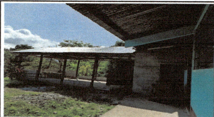
Foto 1: MEJORAMIENTO DE COCINA REPARACION DE COLUMNAS SUSTITUCIÓN DE MADERA POR BLOCK Y POLLETON
